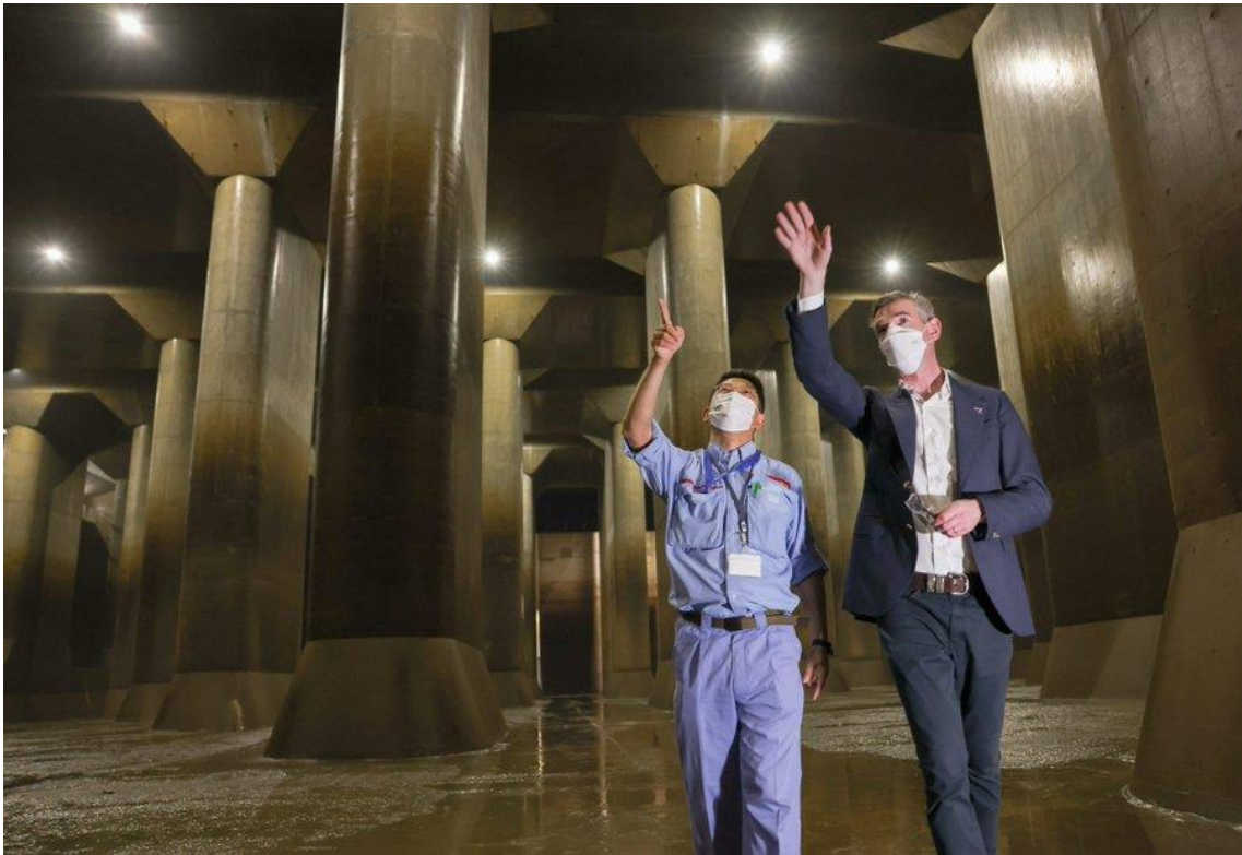
首都圏外郭放水路の視察 (2022 年 7 月 24 日、ペロテー州首相 Twitter)
