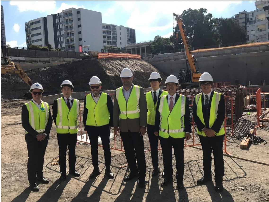
カンタベリー・バンクスタウン市のアスフォー市長他と 西シドニー大学キャンパス予定地の工事現場で (2021年4月26日)
