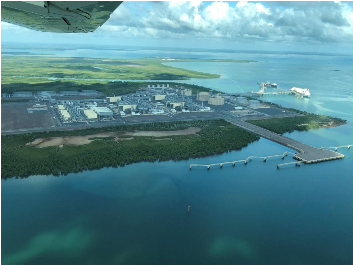
空から見たイクシス LNG プロジェクト陸上プラント施設 (2020 年 10 月 26 日)
